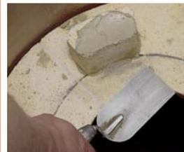
Mörtel auf die drei eingebauten Stützen auftragen
