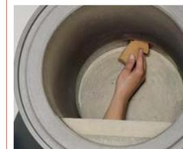
Fuge mit Schwamm reinigen
