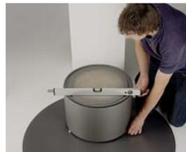
Bodenteil durch Drehen der Verstellfüße waagrecht ausrichten
