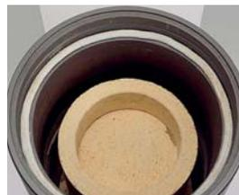
Mörtel auf halben Zugring auftragen, Zugring sofort auf die Zwischenplatte setzen
