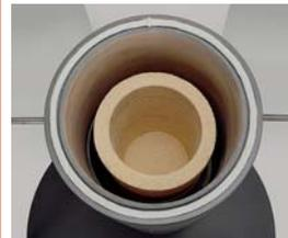
Zugring sofort auf die Zwischenplatte setzen
