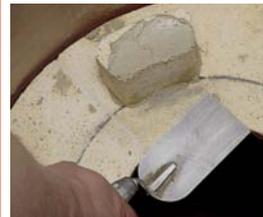
Mörtel auf die drei eingebauten Stützen auftragen
