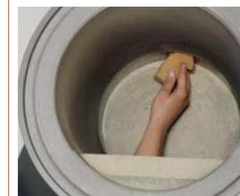
Fuge mit Schwamm reinigen
