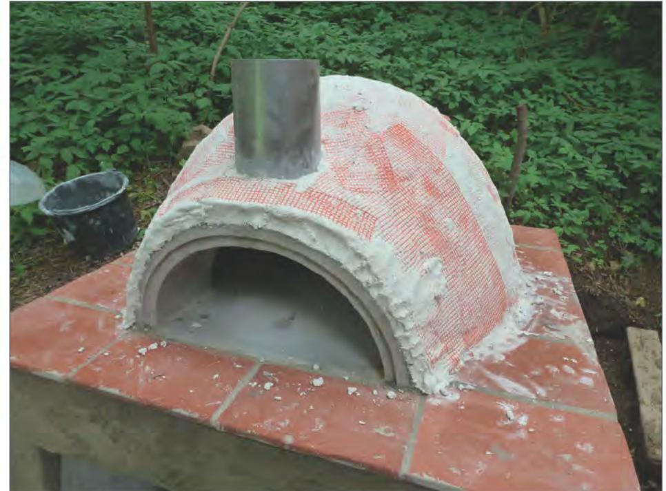
Das Rauchrohr mit Haube auf den fest eingebauten Stützen aufsetzen.
