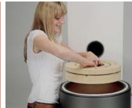
Feuerraumdecke ins Mörtelbett setzen
