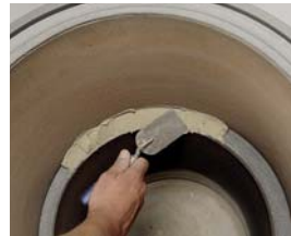
Schamottemörtel auf die Oberseite des Feuerraums auftragen
