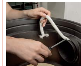
zwei Windungen Dichtschnur mit einem Schraubenzieher in den Spalt zwischen Rauchrohr und Ofenöffnung pressen
