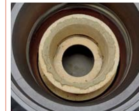
Mörtel mit der Kelle entlang des inneren Randes etwa 1cm dick auftragen und ...
