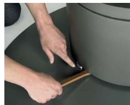
vor Einbau des Rauchrohrs kann die Position und Ausrichtung des Ofens mit Hilfe eines Flachmeißels verändert werden
