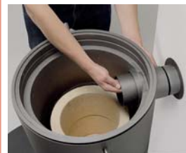
Rosette in den vorbereiteten Kaminanschluss einsetzen und das Rauchrohr von innen auf die Rosette schieben
