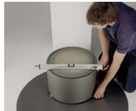
Bodenteil durch Drehen der Verstellfüße waagrecht ausrichten
