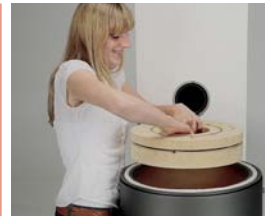
Feuerraumdecke ins Mörtelbett setzen
