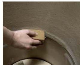
Innenfuge zwischen den Mantelringen mit Mörtel füllen und versäuern
