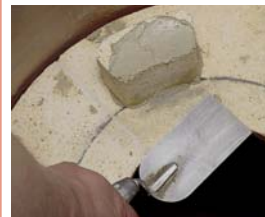
Mörtel auf die drei eingebauten Stützen auftragen
