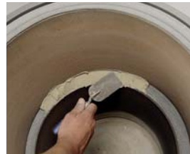
Schamottemörtel auf die Oberseite des Feuerraums auftragen
