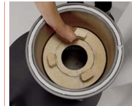
Stützen mit wenig Mörtel auf die markierten Stellen setzen
