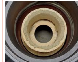
Mörtel mit der Kelle entlang des inneren Randes etwa 1cm dick auftragen und ...
