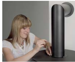
Rauchrohr mit Rosette in den vorbereiteten Kaminanschluss einsetzen und mit drei Inbusschrauben am Deckel befestigen
