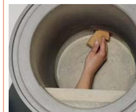
Fuge mit Schwamm reinigen
