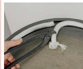
Dichtschnur mit ca. 3 cm Überstand abschneiden (Beißzange, Seitenschneider oder Schere verwenden)
