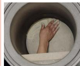
Fuge zwischen Boden und Feuerraum innen mit Schamottemörtel füllen
