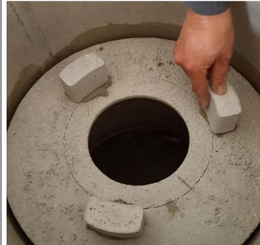
Stützen mit wenig Mörtel auf die markierten Stellen setzen
