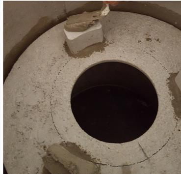
Mörtel auf die drei eingebauten Stützen auftragen
